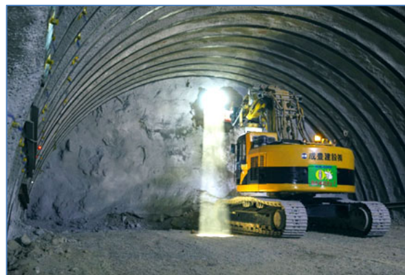
トンネル貫通時 (H31.2)
