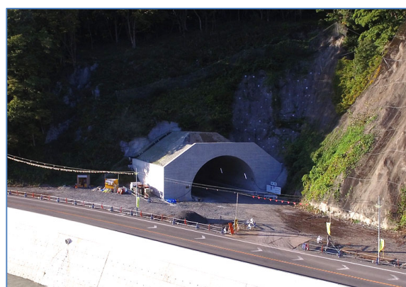
下川井トンネル(仮)宮古側
