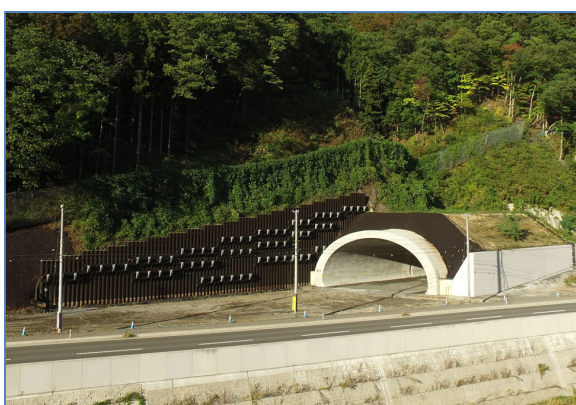
下川井トンネル(仮)盛岡側
